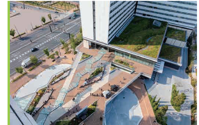
ミチノテラス豊洲 豊洲MiChiの駅 出典：清水建設
